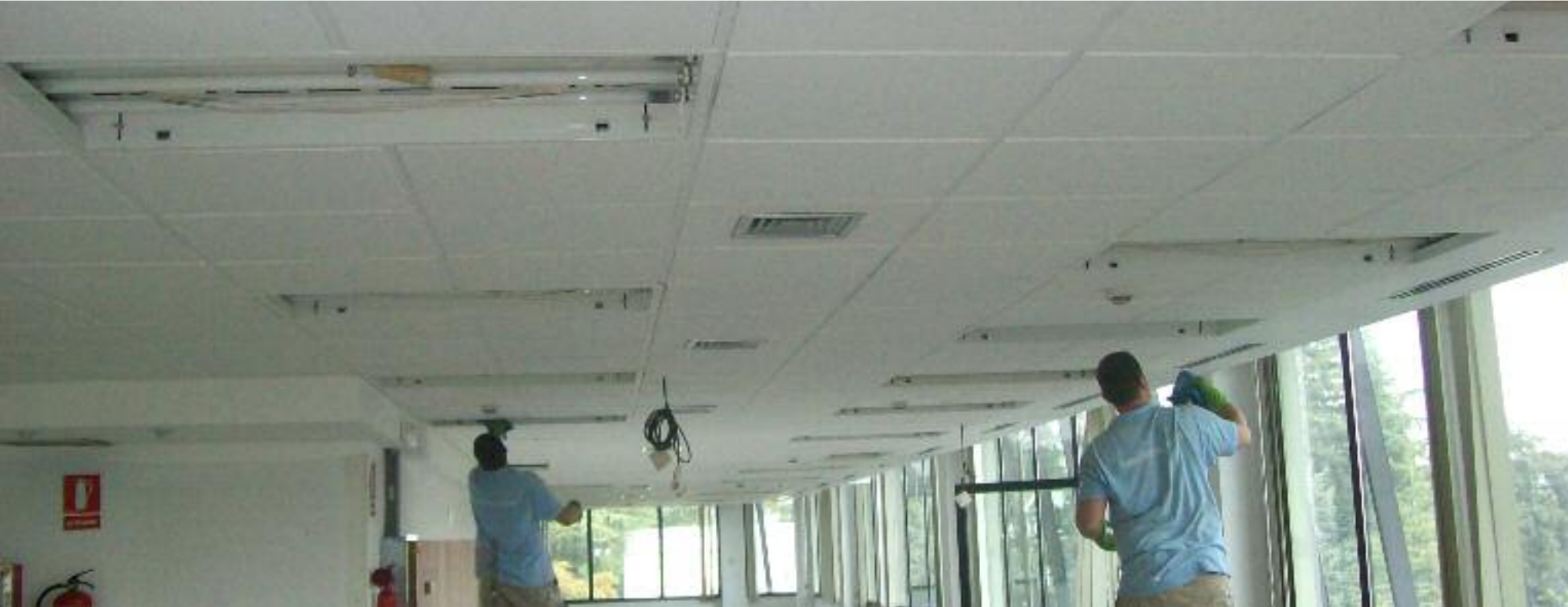
Techo limpio después del tratamiento Reciplac
